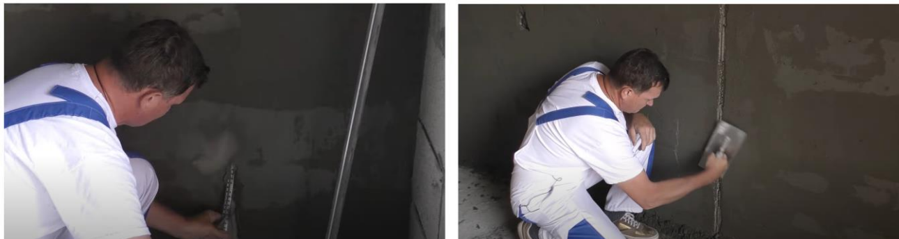
Рис. 33. Схема демонтажа маяков и заделки образовавшихся борозд
