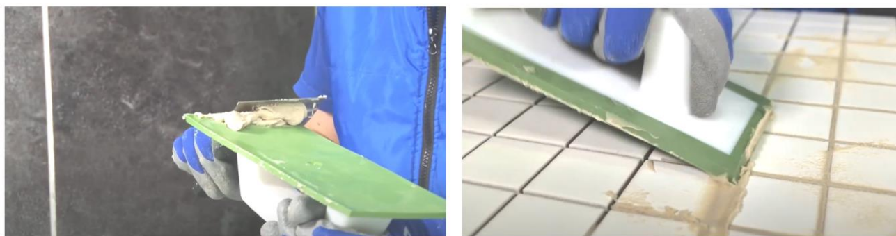
Рис. 39. Заполнение швов затиркой при помощи резинового шпателя
